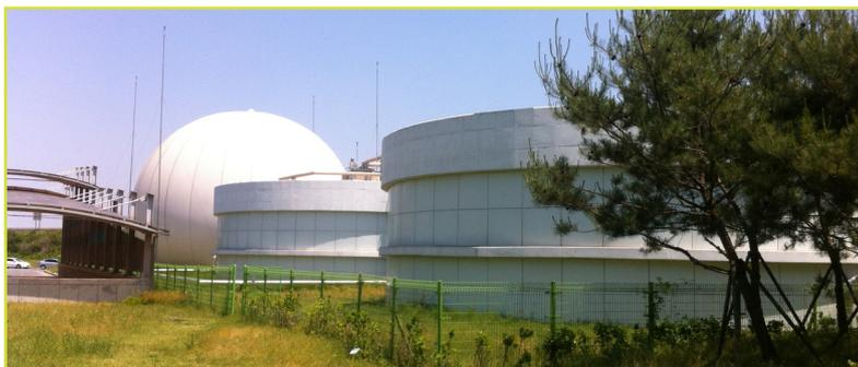
Installation de méthanisation des boues de station d'épuration
